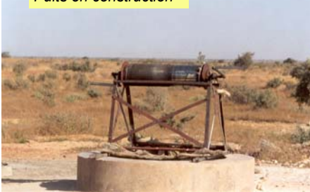
Puits en construction
