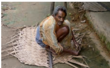
Tressage de feuilles de bambou pour réparer le toit
