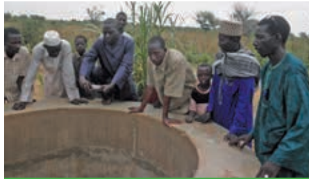
Creusement d'un puits à Talibi Loufayi
