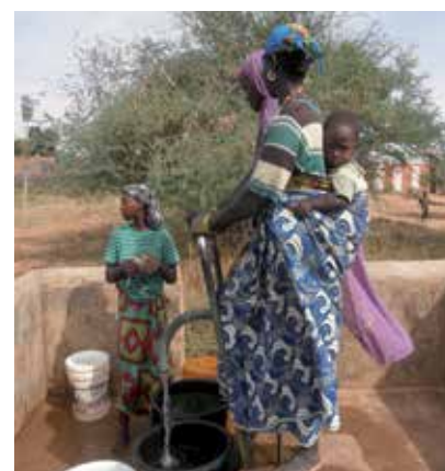
Pompe à pied du forage de l'école à Youmbou Goulma
