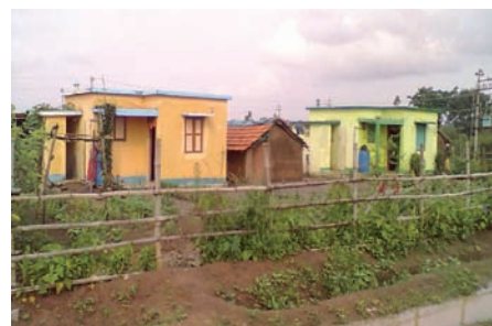
Nouvelles maisons construites par le gouvernement à Shettyhalli
